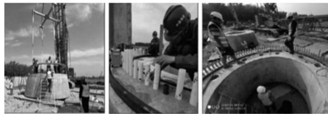
图7 锚板安装及调平
